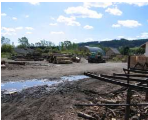
Původní rozbahněný terén
